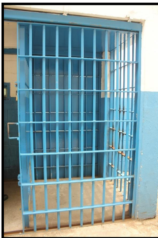
Gaiola de controle de acesso à parte interna da unidade. Fonte: MNPCT, 2023.
