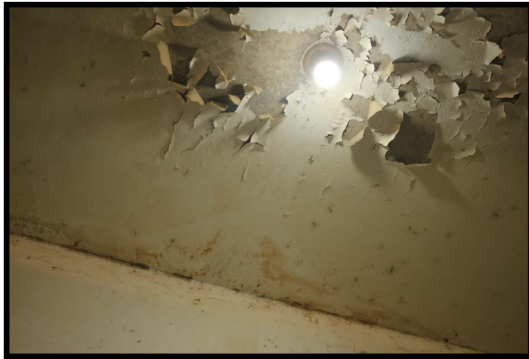
Teto da cela de convívio. Fonte: MNPCT, 2023.
