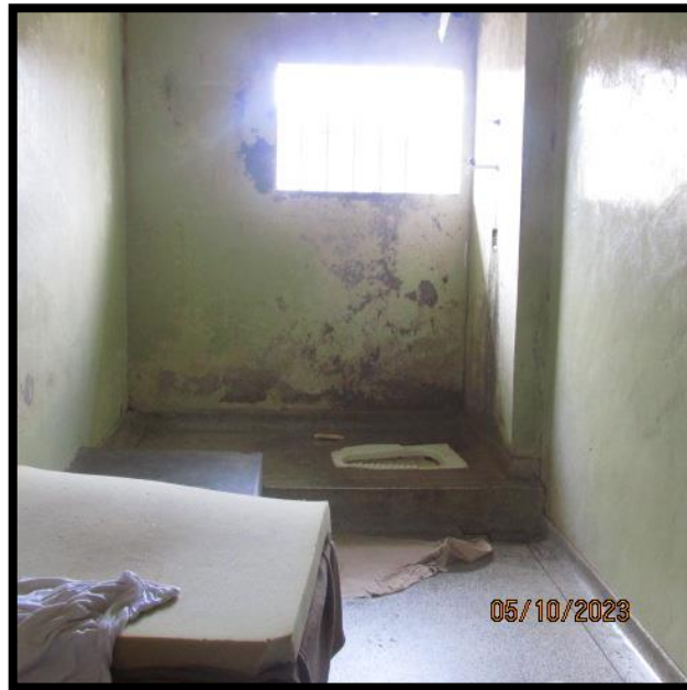
Cela de isolamento. Fonte: MNPCT, 2023.
