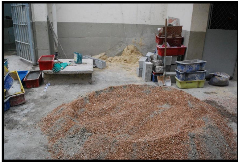
Reforma da cozinha. Fonte: MNPCT, 2023.
