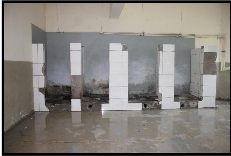
Área dos “duchões” no pátio de banho de sol. Fonte: MNPCT, 2023.
