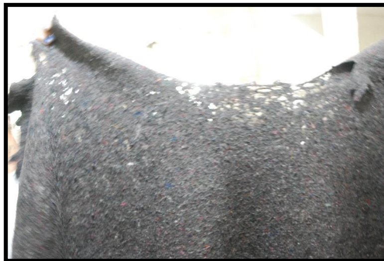
Coberta velha e desgastada. Fonte: MNPCT, 2023.
