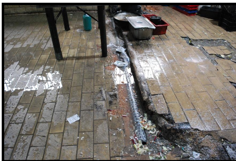
Cozinha. Fonte: MNPCT, 2023.
