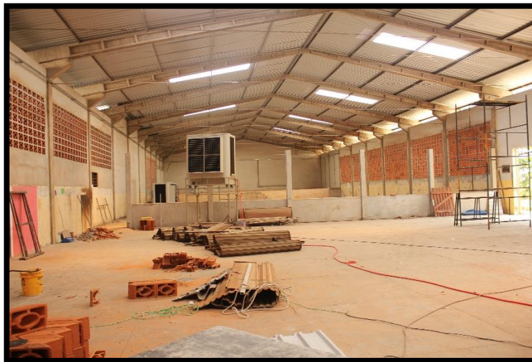
Espaço em reforma. Fonte: MNPCT, 2023.
