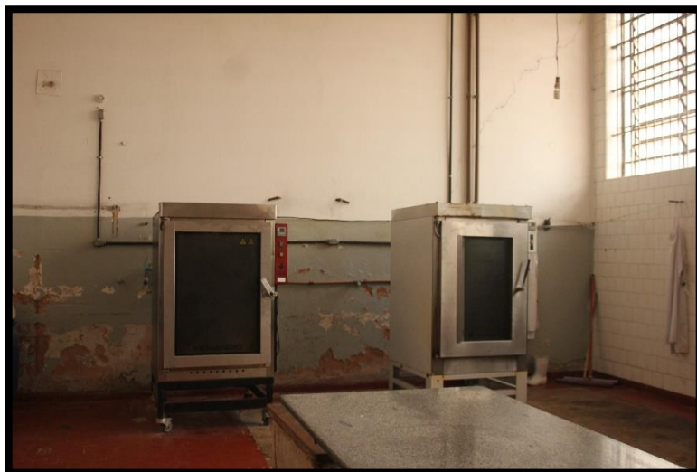
Cozinha. Fonte: MNPCT, 2023.
