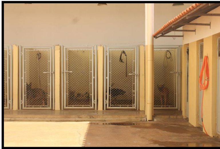
Canil do GIR. Fonte: MNPCT, 2023.
