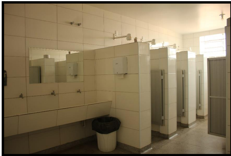
Banheiro coletivo. Fonte: MNPCT, 2023.
