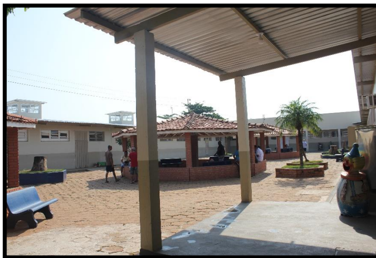
Pátio externo. Fonte: MNPCT, 2023.
