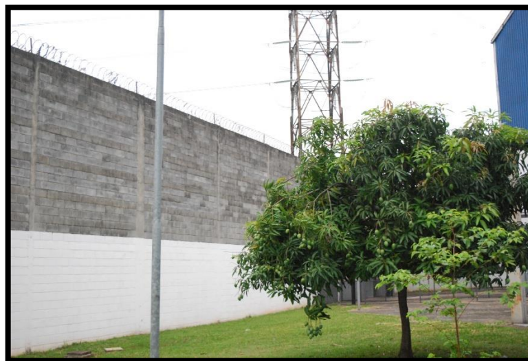
Muro que cerca a UES.
